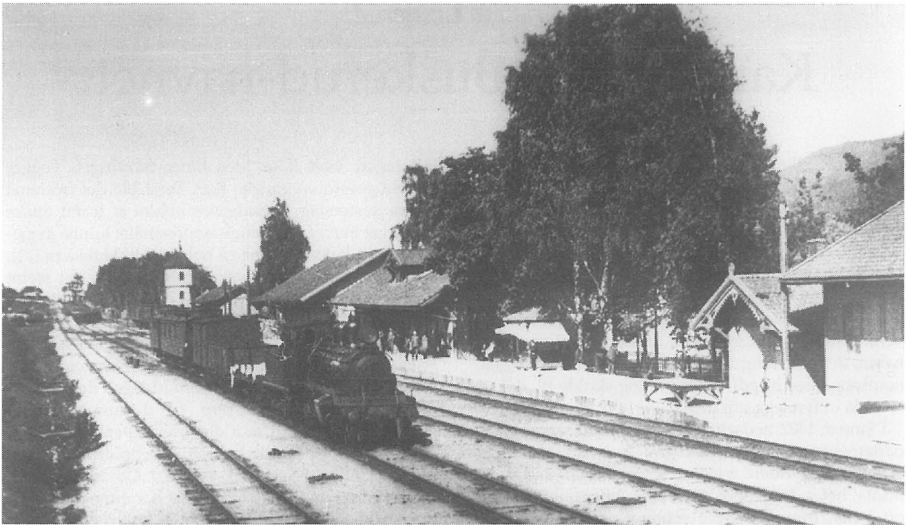
Dette bildet er fra Vikersund stasjon der vi kan se det kjente vanntårnet i bakgrunnen og et forholdsvis lite tog. Det er også mye som tyder på at banen ennå er snalsporet, altså fra før 1906.
