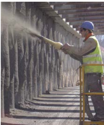
Betonpompen zoals de P 715 hebben één van de meest veelzijdige systemen. U kan ze gebruiken om beton te spuiten of voor het verpompen van ...
