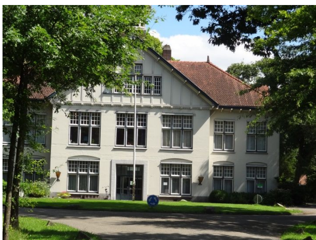
Fig. één van de historische panden op het Altrecht-terrein
