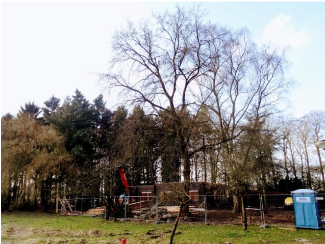
Fig: sloop van de Finse villa's is al in volle gang.
