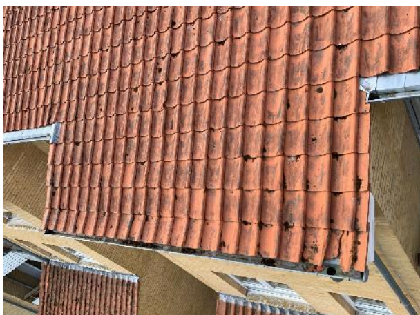
Område med forvitret tegl. Tegl blev så vidt muligt udskiftet.
