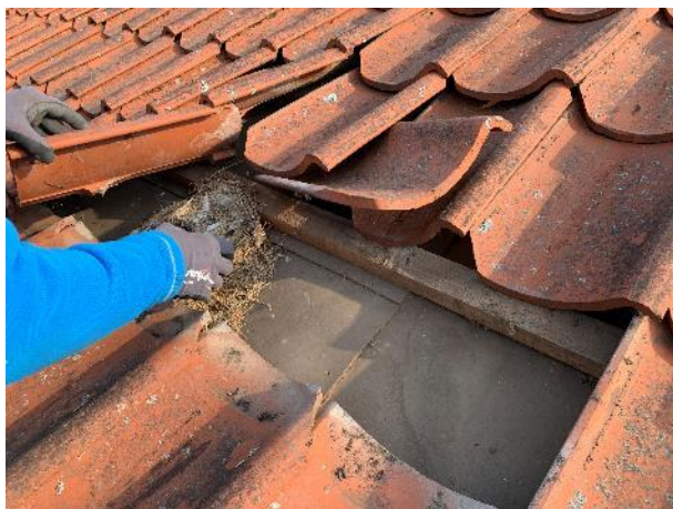
Hultagning 10. Fugleredde ved tagfod er en generel udfordring.
