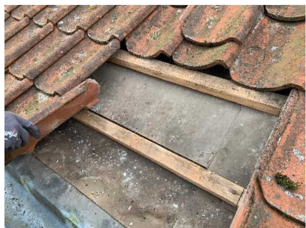
Hultagning 27. Nederste lægte i mindre dimension end øvrige.
