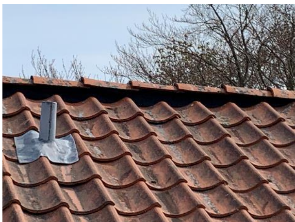
Rygning over Mikkelborg Park 15. Ligger med stor afstand til tegl.
