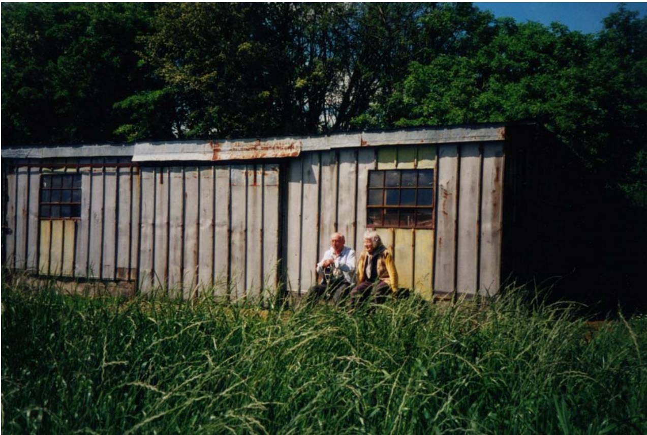
Dette foto viser kostalden i engen. Den blev bygget i 1973. Billedet er taget den 13/6 2001.
