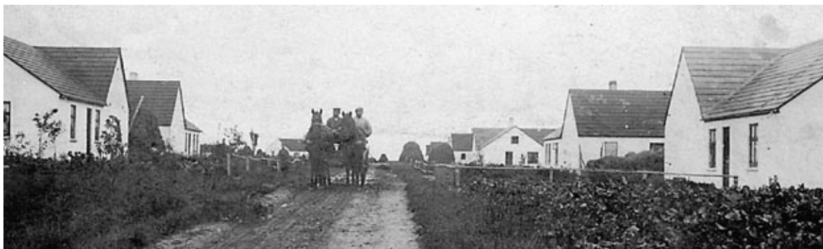
Sundby »hovedgade« omkring 1920.
