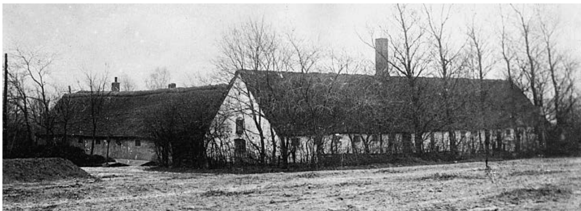
Søndergade 9. Den gamle gård før branden i 1926.
