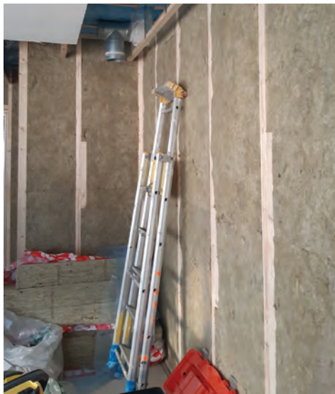
Lydisolering av alle rom er gjennomført
