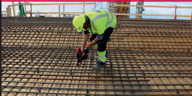
Grande barre d'armature/Pont
