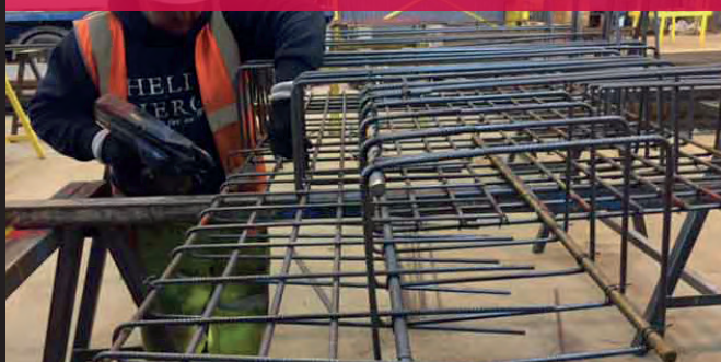
Préfabriqué en usine
