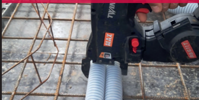
Liage des fourreaux en incorporation
