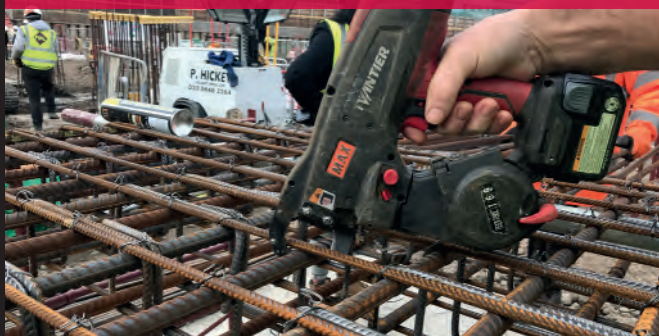
Cage d'armatures de bâtiment
