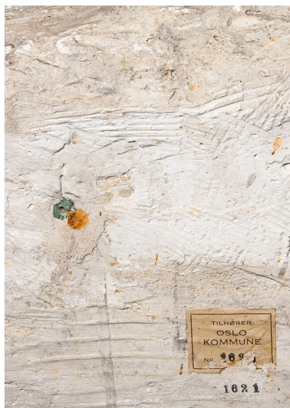
Figur 17: Detaljfoto av plinten viser rester av en korrodert kobberstav som en grønn flekk på overflaten.
