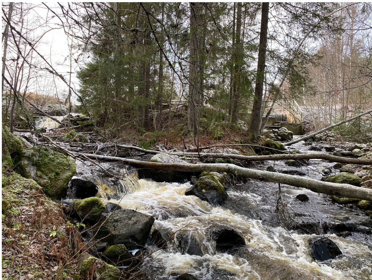
Figur 4. Dammen fotad i uppströms vinkel. Den vänstra fåran har en högre inneslutning vilket gör det enklare att höja basnivån. Fallhöjden är dock fortsatt väldigt hög vilket kan göra det utmanande att få en fungerande passage i alla flöden.
