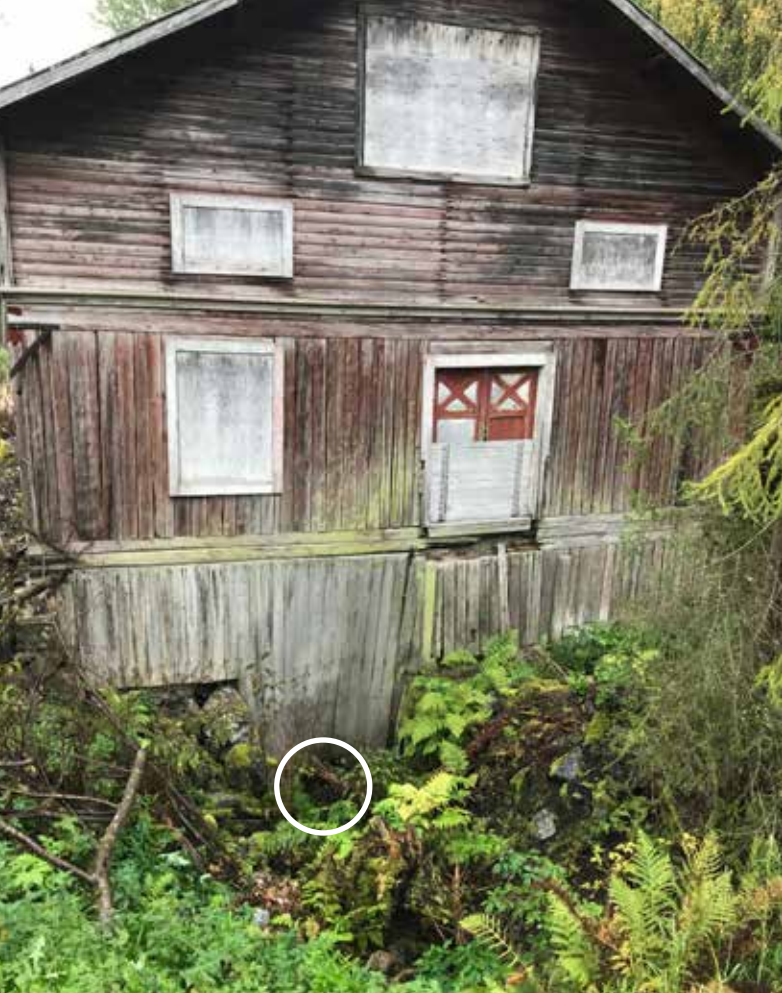
Ovan till vänster den bevarade kvarnbyggnaden med spår efter en vattentub. Tuben var in-grävd i dammvallen och vidare in i byggnaden, se den runda ringen. (Foto: Hugin&Munin).
