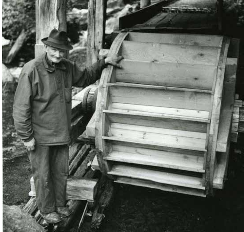
Fotot ovan visar ett överfallshjul till Växbo kvarn i Trolldalen, Hälsingland. Ovanför vattenhjulet skymtar rännan som förde vattnet ner på hjulet. Även hamrarna drevs av högt överfall och krävde därför inte så mycket vatten (Norberg 1960).
