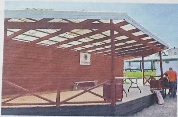
Scenen som redan fanns på planen har rustats upp.
