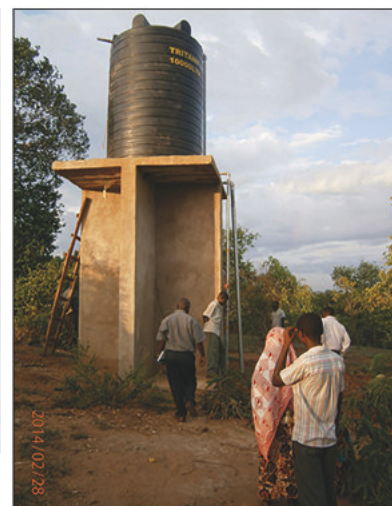
En av fyra vattentorn.
