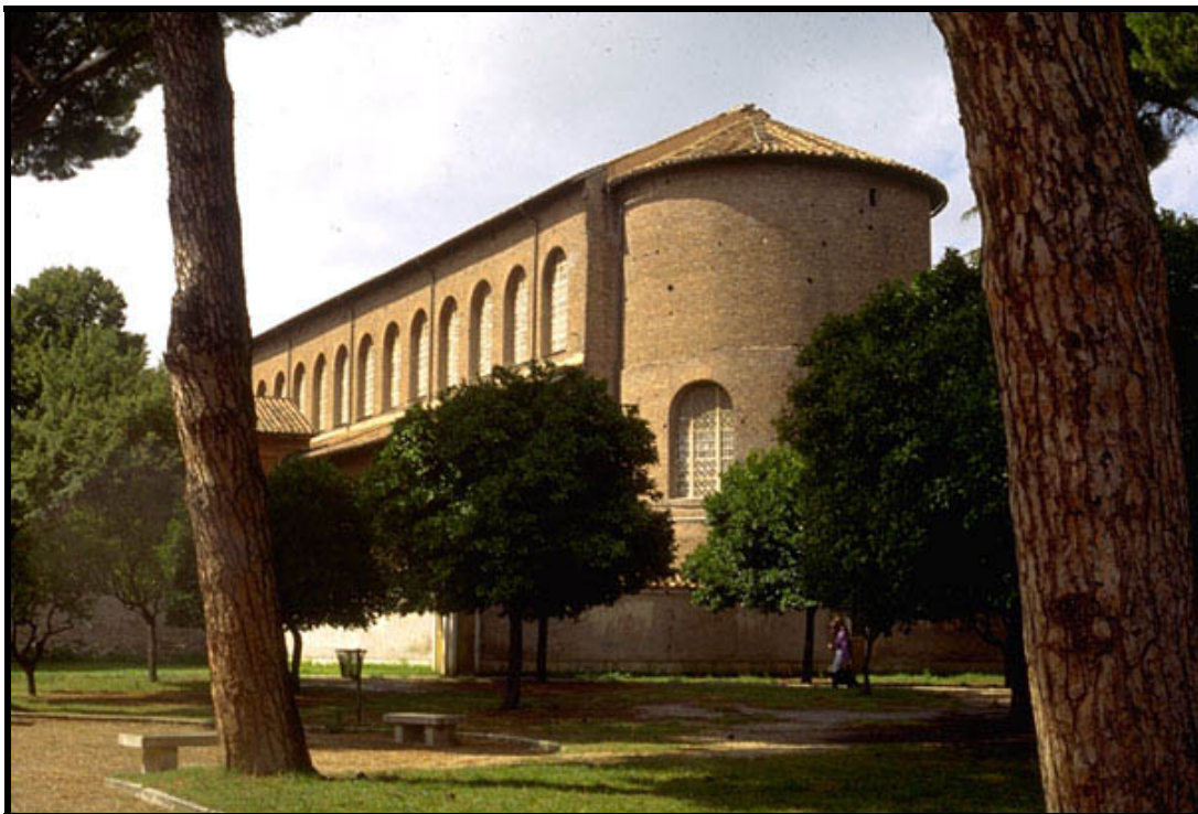
Figur 1. Santa Sabina, Rom (422-432). Oldkirkelig basilikas eksteriør med karakteristiske udekorerede murstensflader domineret af store vinduer. Idet disse oldkirkelige basilikaers facader oprindeligt kan have været pudset, stemmer deres nuværende udseende muligvis ikke overens med kirkernes oprindelige fremtoning. Det fremgår dog tydeligt, at interiørets frem for eksteriørets udsmykning blev prioriteret.
