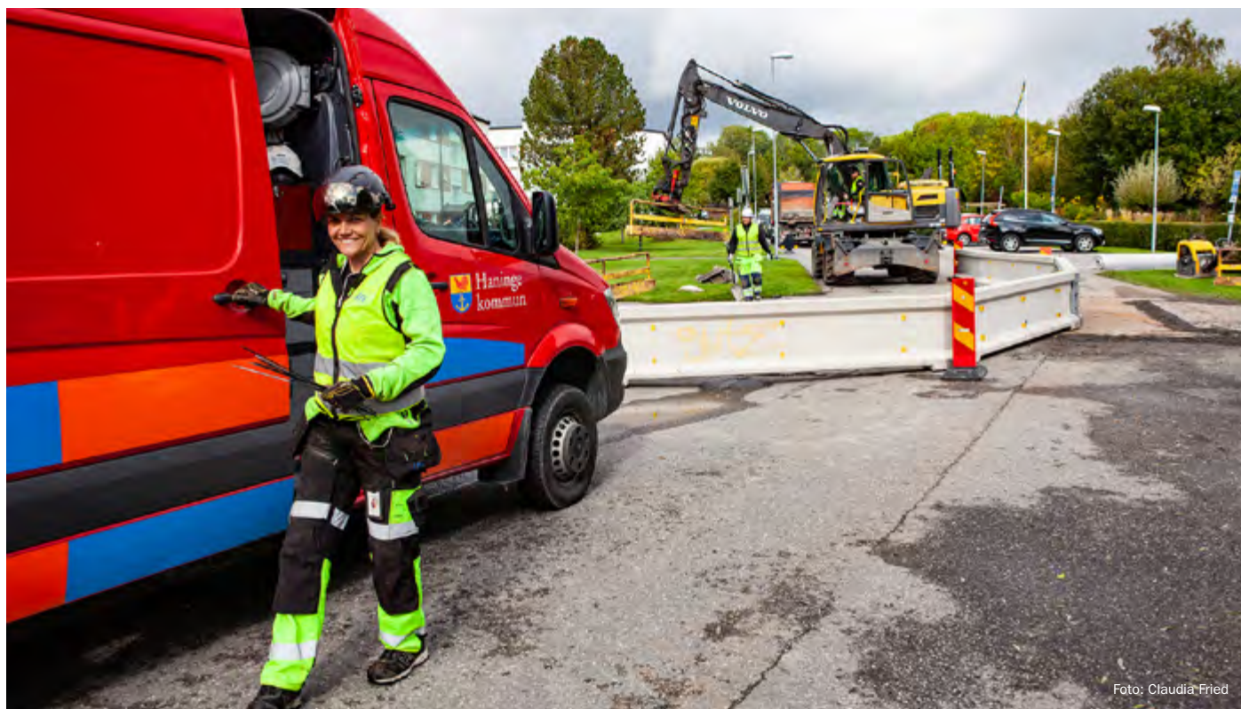
Bild 7. Ledningsarbete. Kommunen har ca 370 km dricksvatten ledningar och ca 250 km spillvattenledningar.
