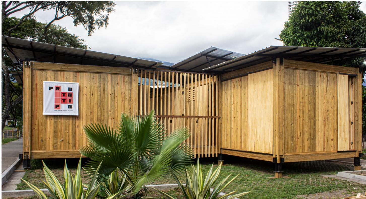
El prototipo de vivienda funciona como ensayo para el futuro desarrollo de estructuras de madera en Venezuela, fabricadas de forma serializada con elementos prefabricados que sean de fácil transportación y montaje, y promover el desarrollo de normas y certificaciones para este tipo de edificaciones.
