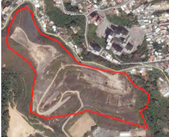
Complexe résidentiel El Joropo 1, proposition 006, 360 logements, La Lagunetica, Los Teques. Source: Plan de Gestion 2014
