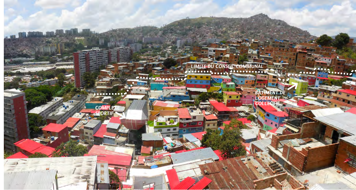
Vue panoramique du quartier de Carbonell. Si le complexe sportif se détache clairement dans le paysage, on ne note pas la présence du petit immeuble de logement construit par le Conseil Communal (qui a les mêmes caractéristiques typologiques que les autres constructions du quartier). Il est intéressant aussi de noter la limite claire des maisons qui ont bénéficié d'une intervention (en couleur) et de celles qui n'en ont pas bénéficié, qui correspond à la limite du Conseil Communal.
