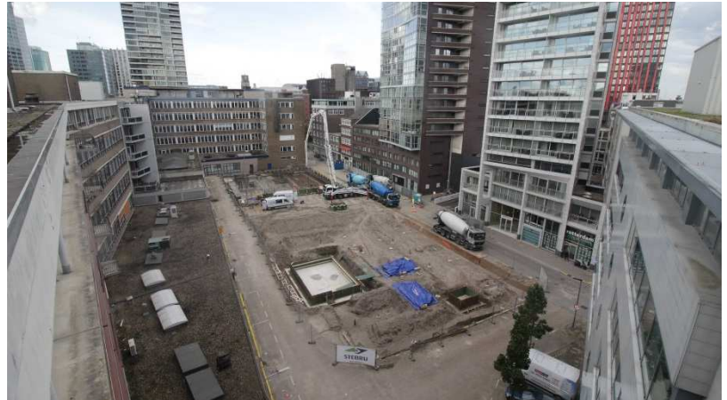
2 vrachtwagens aan de betonpomp, 2 vrachtwagens staan klaar om te lossen
