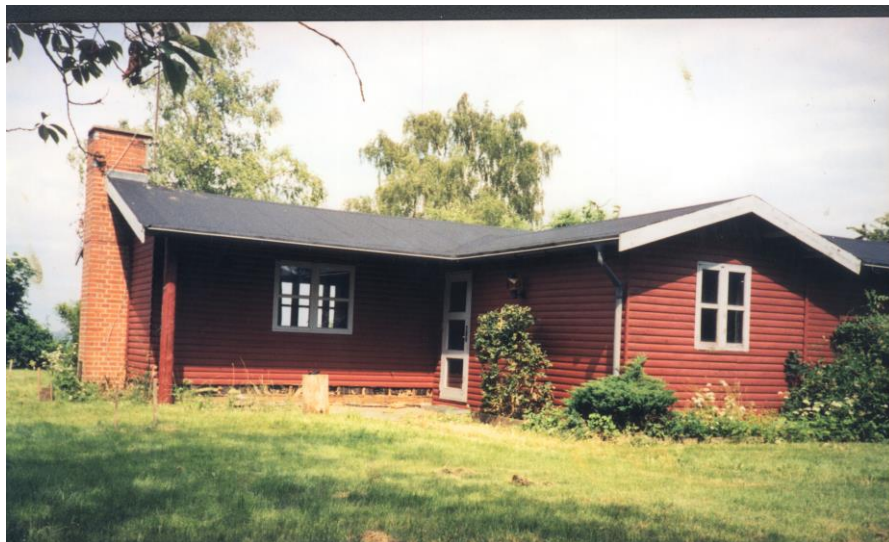
Bautavej 13 er stort set uændret siden 1960 - foto omkring 1998
