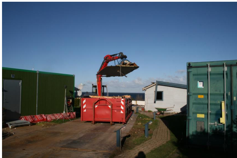
Bautavej 9 i 2007 - I omkring to år er pladsen besat med containere - Jan, Jarl og Marianne bor i beboelsescontainerne til venstre under byggeriet
