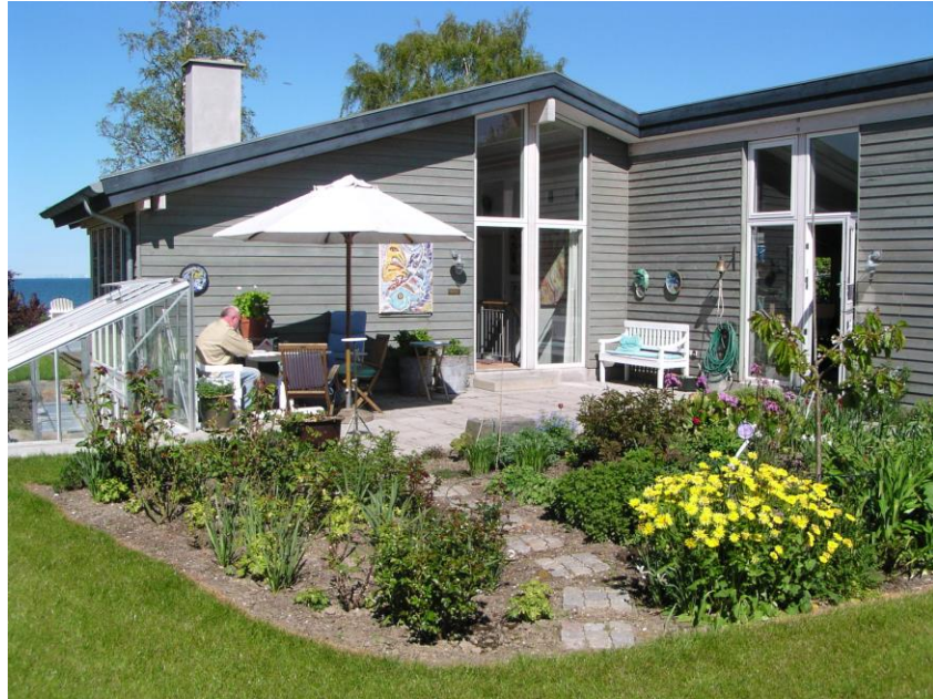
Det nybyggede hus på Bautavej 13
