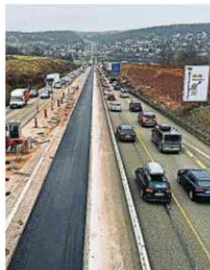
So kennen die Autofahrer die Erzschenke mit Baustellenspuren und asphaltiertem Mittelstreifen, um dem Verkehr in der Bauzeit mehr Platz zu geben.
