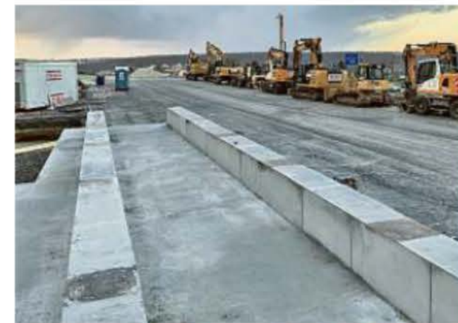
Die Infrastruktur für die Riesenbaustelle ist seit Oktober eingerichtet worden.
