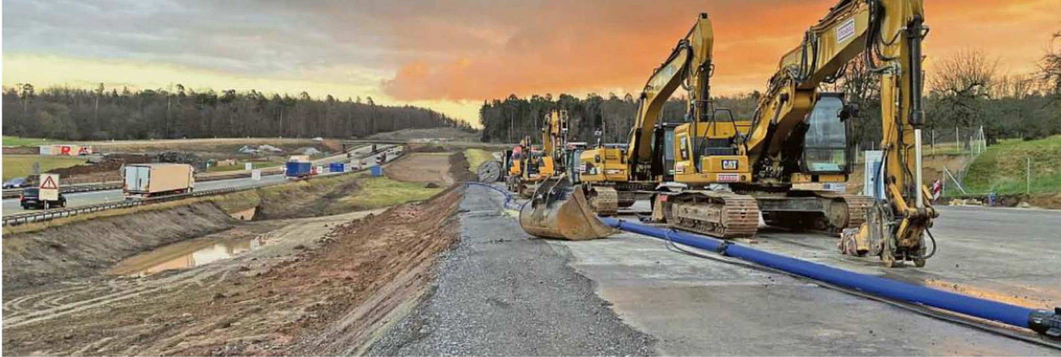
Schwere Bagger warten auf einer Baustraße neben dem A8-Anstieg bei Niefern Richtung Stuttgart auf den nächsten Einsatz. Der Boden für die sechsspurige Autobahn wird schon bereit.
