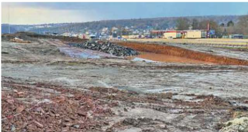
Eine Menge Erde ist schon bewegt worden, noch viel mehr muss für die neue Trasse umgegraben werden. Im Hintergrund: die Raststätte Pforzheim.
