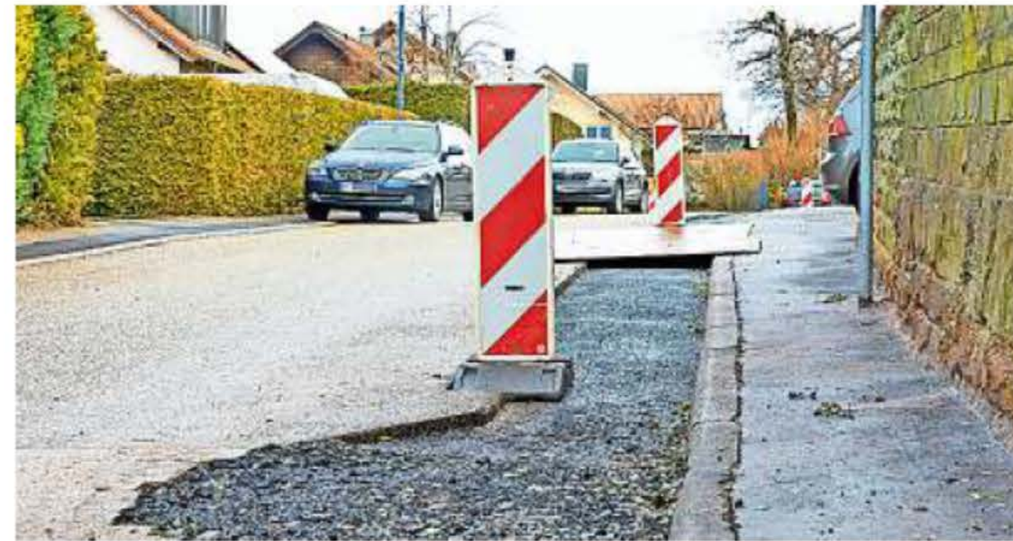
Die typischen Ausfräsungen für die Glasfaserleitungen wird es 2022 in vielen Enzkreis-Gemeinden geben – wie hier bereits im Engelsbrander Heckenweg. FOTO: MORITZ
