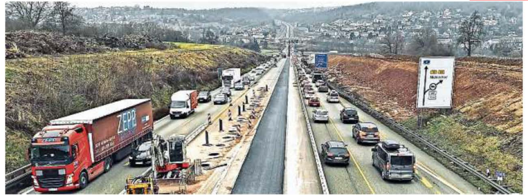
Die Vorbereitungen laufen schon für die mehrjährige Baustelle an der A 8 durchs Enztal. 2022 geht es dort so richtig los. FOTO: STEINERT
