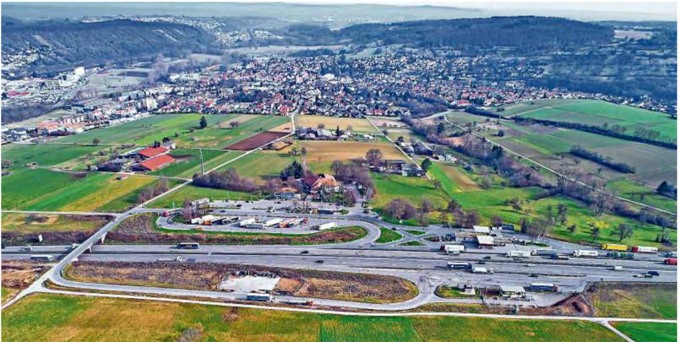
Die bestehende Raststätte Pforzheim (Bildmitte) mit der Brücke (links), die noch im Oktober gesperrt wird. Damit wird die Rastanlage endgültig vom Verkehr in Richtung Stuttgart abgehängt.
