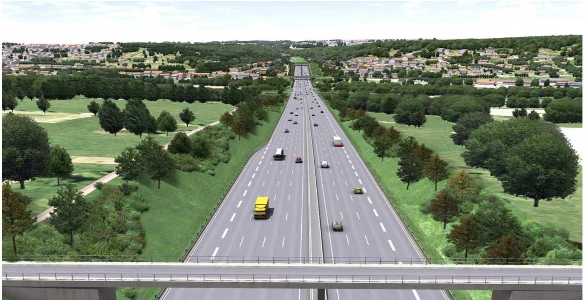
Blick von der Wirtschaftswegbrücke bei der Tank- und Rastanlage in Fahrrichtung Karlsruhe
