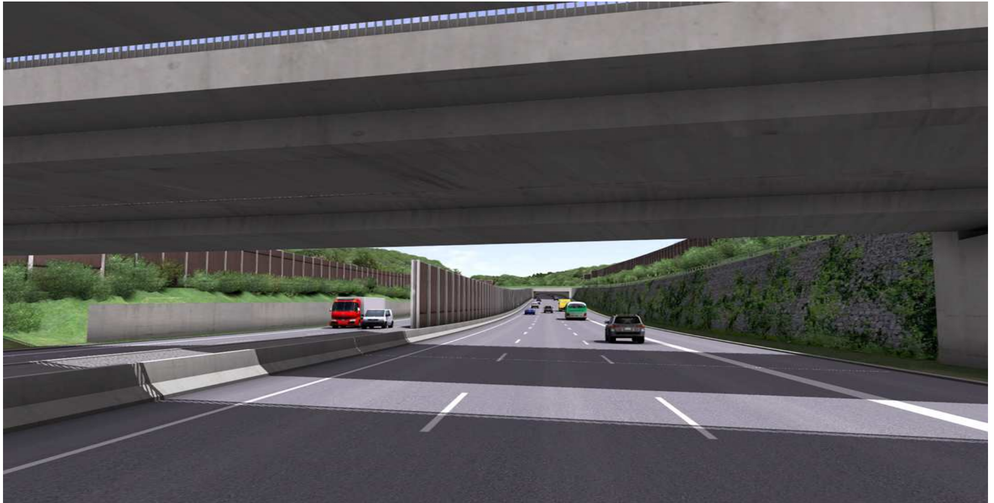
Überführung K 9808 und Bahnlinie, Blick in Fahrtrichtung Karlsruhe
