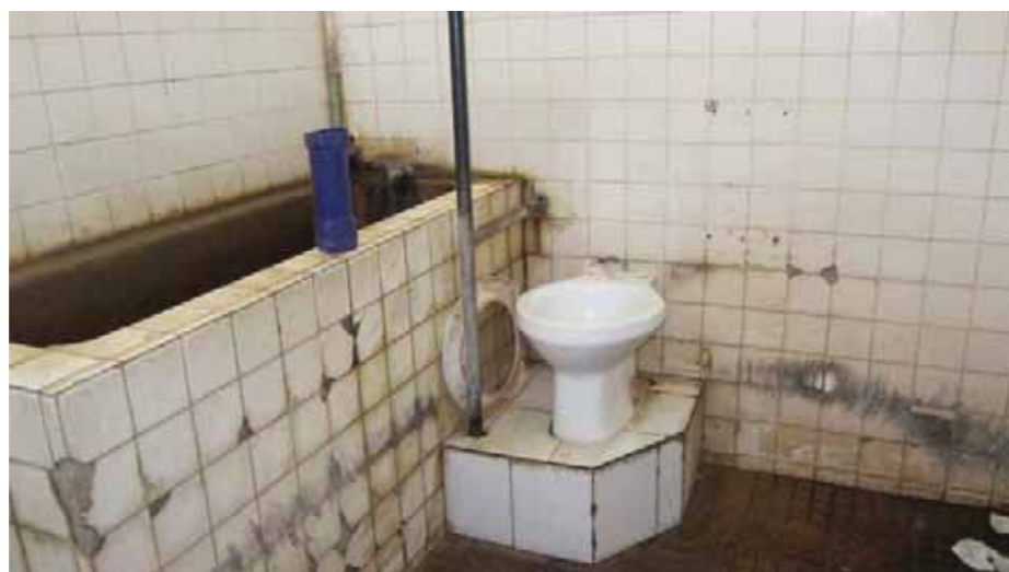
Toalettfasilitetene på rehabiliteringssenteret i Battamban. Ille!
