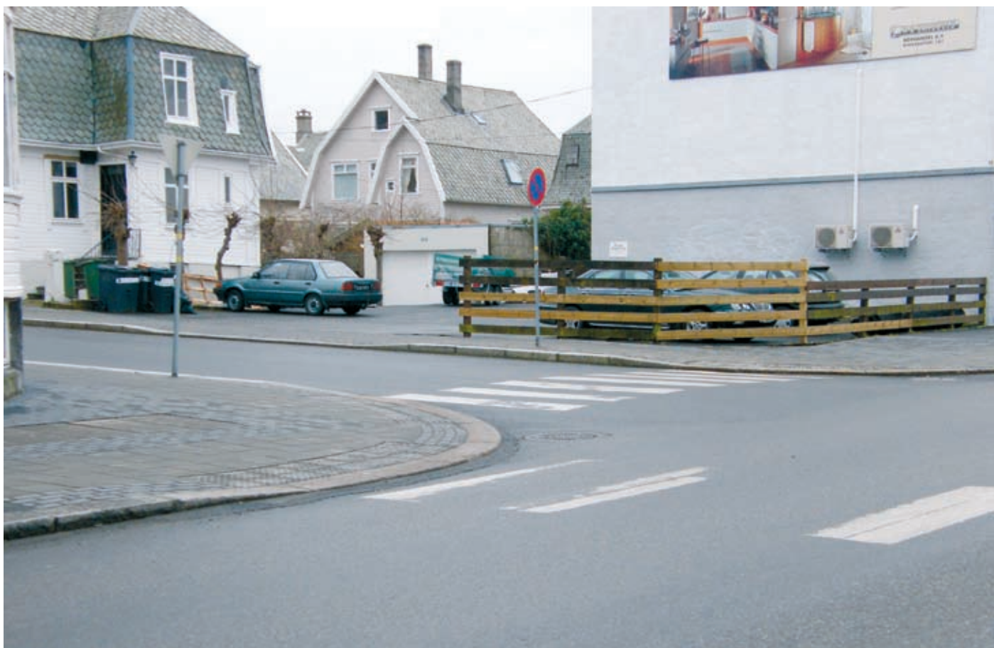
Skjoldavegen. Eksempel på tilrettelagt veikryss. Ingen unødvendig høye fortauskanter.
