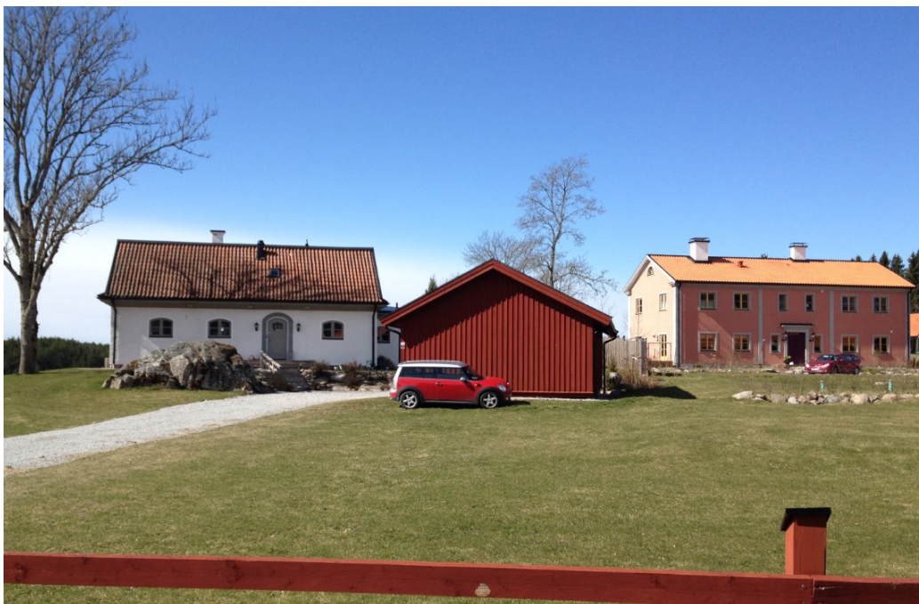
Den vita mindre byggnaden är Länna 1:21, en befintlig komplementbyggnad, som byggts om till bostad. Byggnaden till höger är nybyggd på fastigheten 1:23.
