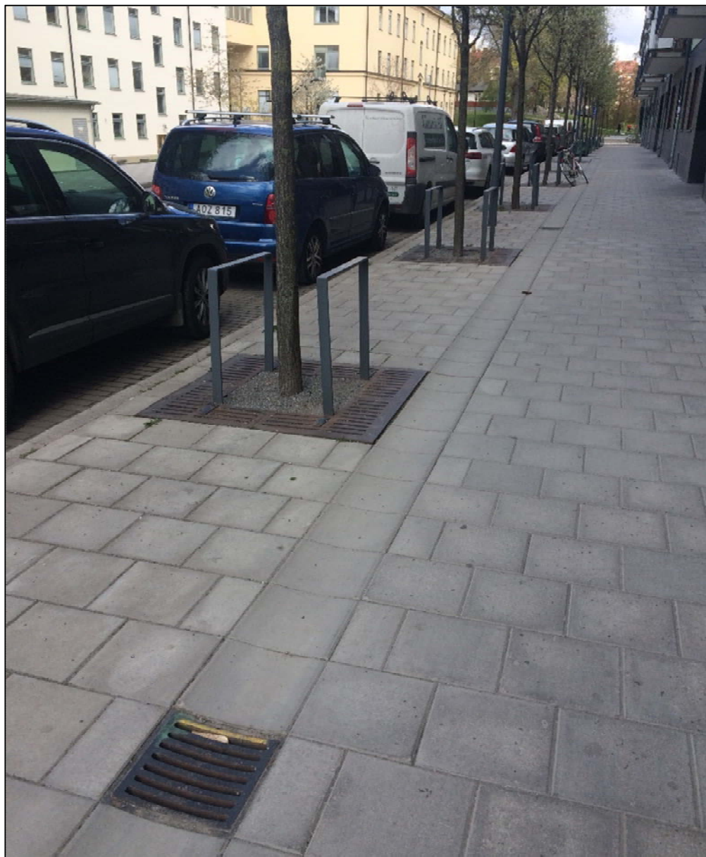
Figur 6-2. Brunnar i en nedsänkning i trottoaren kan förse träden med såväl luft som vatten (foto Frida Hammar, Geosigma).
