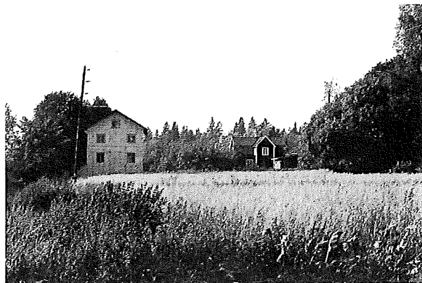
Kvarnhuset och den f.d. mjölnarbostaden vid Länna kvarn.
