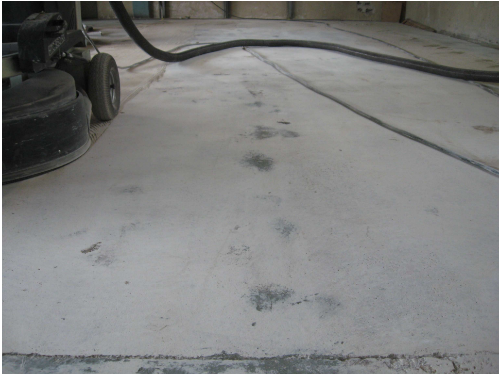
Bild 3. Golv slipat en gång. Då golvet är ojämnt finns fläckar som inte slipats alls efter första slipningen. Totalt slipades tre gånger. 2011-05-24.
