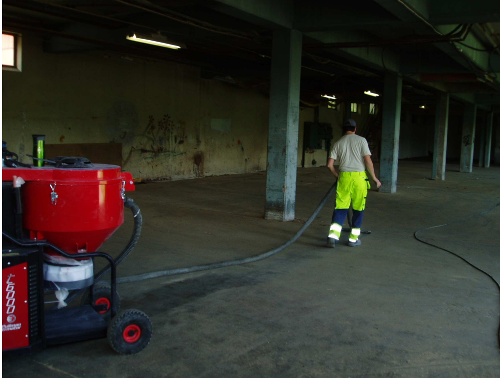
Bild 1. Dammsugning av golv innan slipning påbörjades. 2011-05-19.
