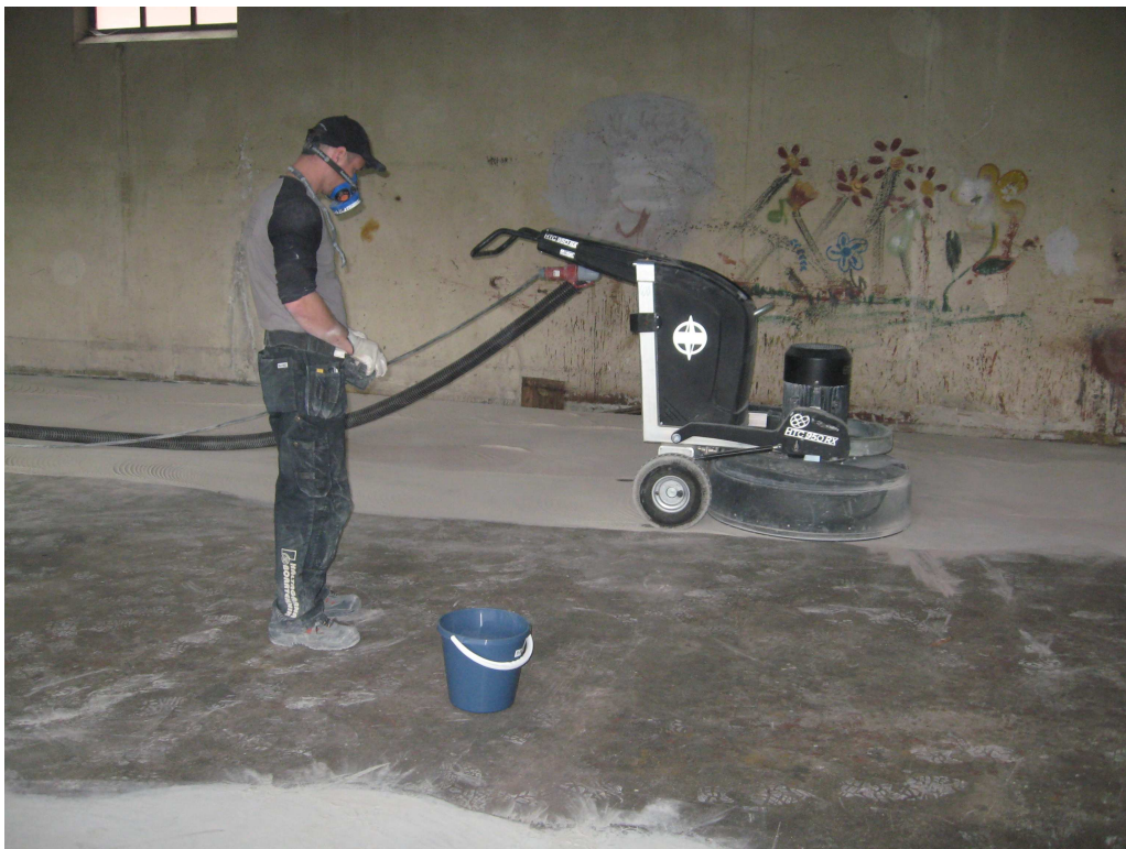
Bild 2. Slipning av golv. 2011-05-24.
