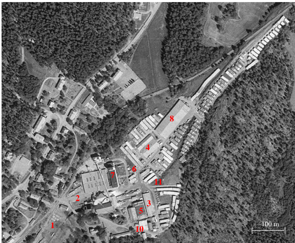
Figur 2-1. Översikt av Lännaholms bruk med numrerade delområden (flygbild från 1971) 1=timmersortering, 2=lagerplats (slaggrester och barkning), 3=kap, 4=gamla torkhuset, 5=nya torkhuset, 6=dopningskar, 7=förvaring av tunnor med PCP-salt, 8=virkeslada, 9=virkesupplag (stabbar, finns över stora ytor inom bruksområdet), 10=dieseltank med handpump, 11=ytvattendrag, markeringen avser slutet av kulvertering. Norr uppåt.
