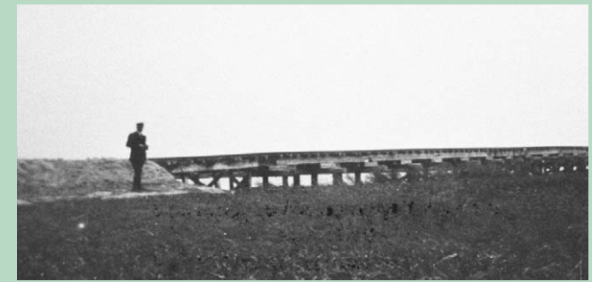
Die Mergelbahnbrücke über Ribe Holme in 1930. Jens Bruun-Petersen/H. Theuts Samling/Sydvestjyske Museer.
