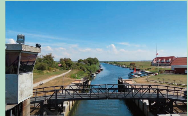
Die Kammerschleuse wird beim Sturmflut geschlossen und in dieser Weise werden die Bewohner der Marsch gesichert. Foto: Charlotte Lindhardt.
