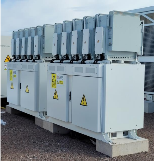
Figur 11. Exempel på stativ med växelriktare.
