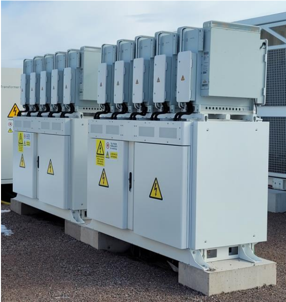
Figur 11. Exempel på stativ med växelriktare.
