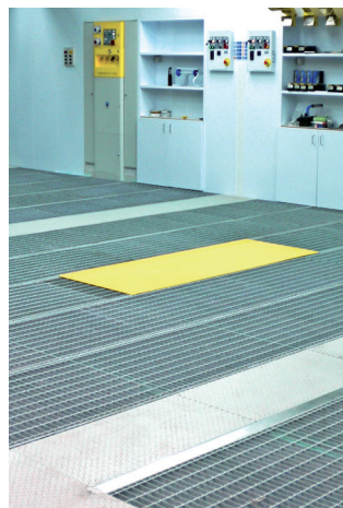
Vorbereitungsplatz mit Gitterberostung und Hebebühne
