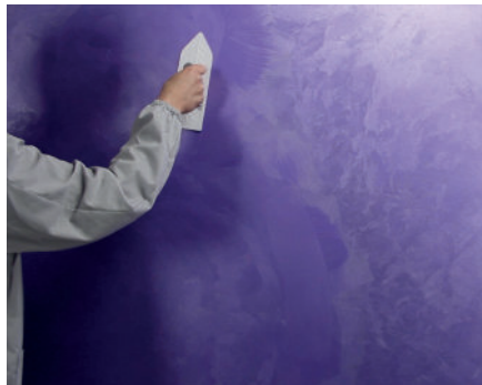
Smoothing Glätten zweiter Anstrich mit Kunststoff-Spachtel
