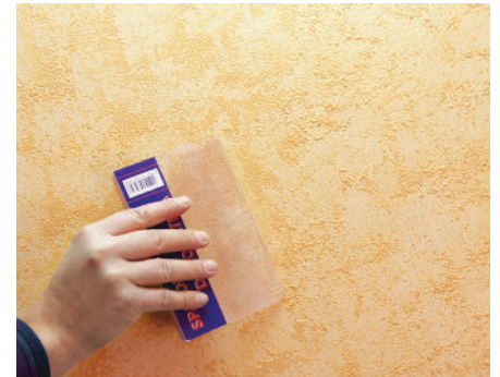
Zweiter Anstrich mit speziellem Doppelklingen-Spachtel Code 1016
