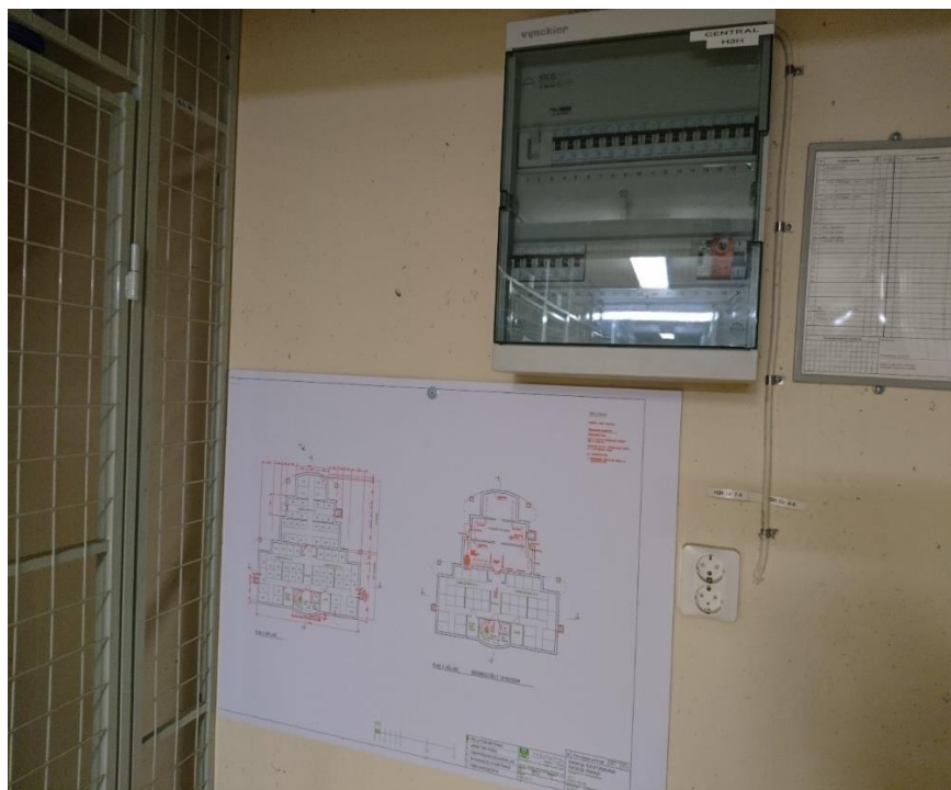
Bild 1. Elcentral/gruppcentral (på västra väggen), arbetsritning/iordningställanderitning
