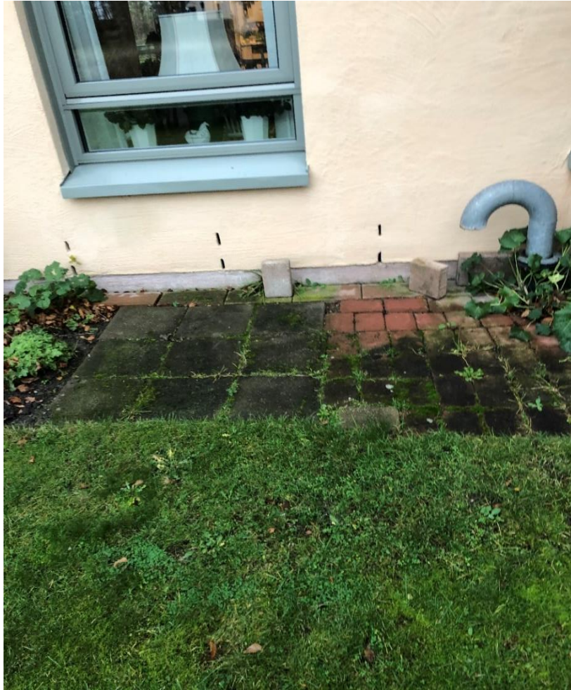
Bild 35. Till vänster: plats (under de 9 betongplattorna rakt nedanför fönstret) för öppning för reservutgång öster Till höger: plats (på rörlänsen, sedan befintligt luftintagsrör monterats bort) för montering av uteluftskanal öster
