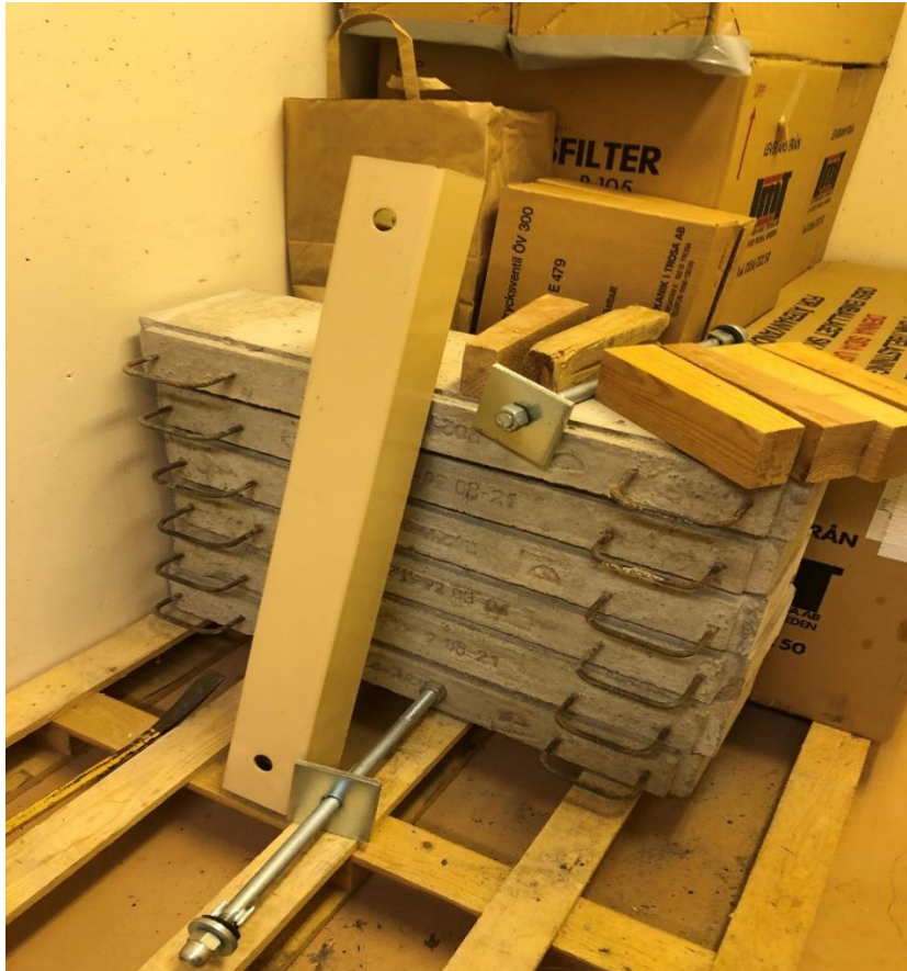
Bild 27. Betongelement (6 st), fördelningsbalk, rundstänger (2 långa bultar) och tråkilar (6 st) för igensättning av reservutgång väster
