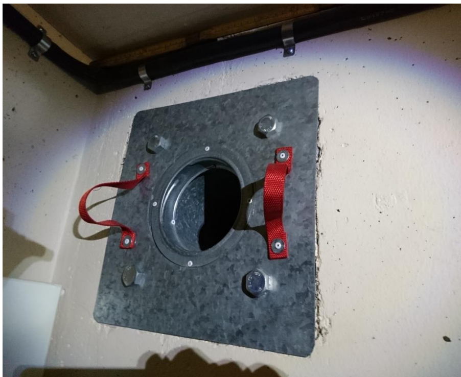
Bild 18. Plats (i förråd 312) för skyddsplåt för igensättning av fredsluftutsug (på bilden är det vita frånluftsdonet bortmonterat)
