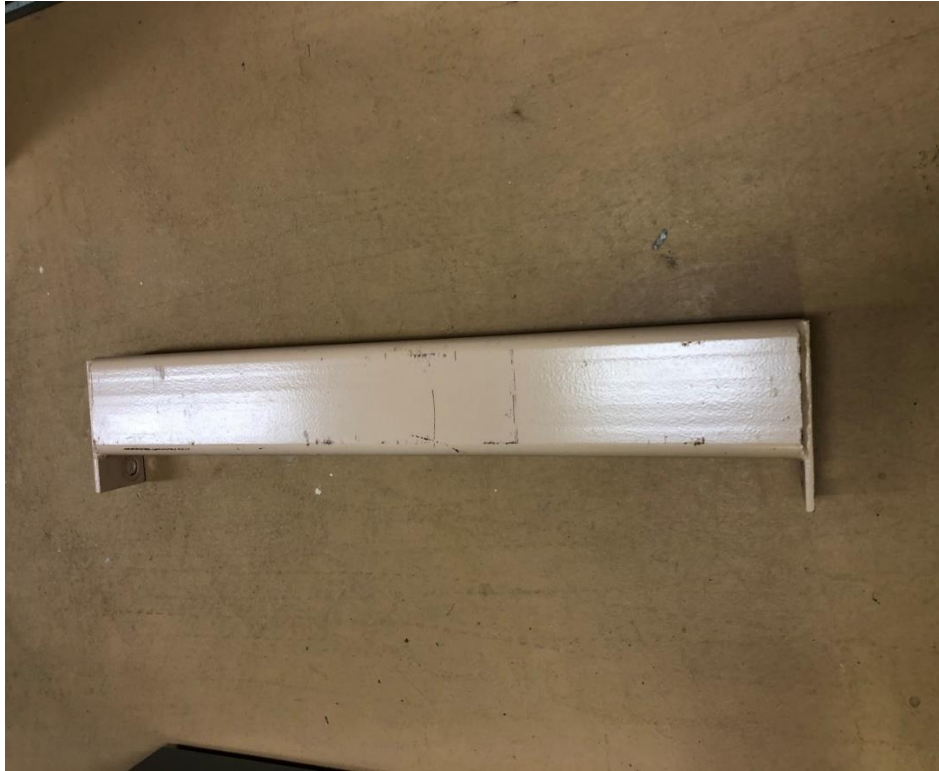
Bild 21. Tröskel till skyddsrumsdörren (befintlig fredsdörr ska monteras bort)
