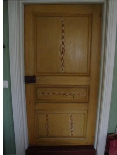
1700-talsdörr med ådringsmålning
