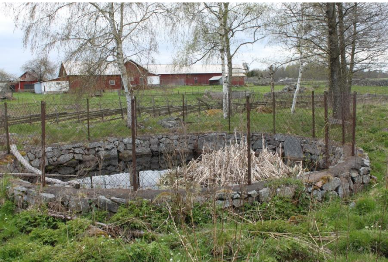
Brandbrunn i Krokshult byggd på 1950-talet
