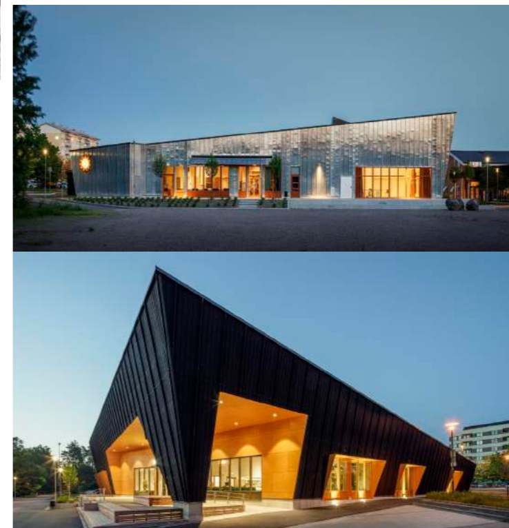
Kronoteket ungdomsgård, Karlstad, Tengbom
