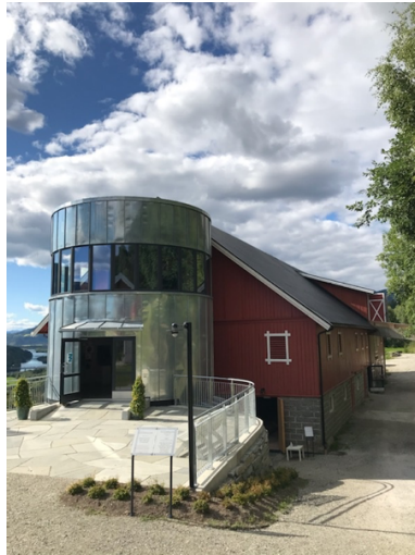
Stedet for seminaret: Ringebu Prestegard, driftsbygningen. Her er alle rommene til SKK lokalisert i fire etasjer. Siloen foran bygget fungerer som galleri for Ringebu barnehagenes utstillingslokale. Foto: Randi Grov Berger.
