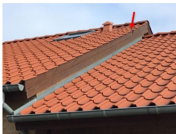
| Vindskede med vridskader.
