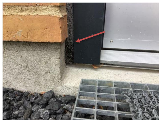
Nedbrudte fuger.
