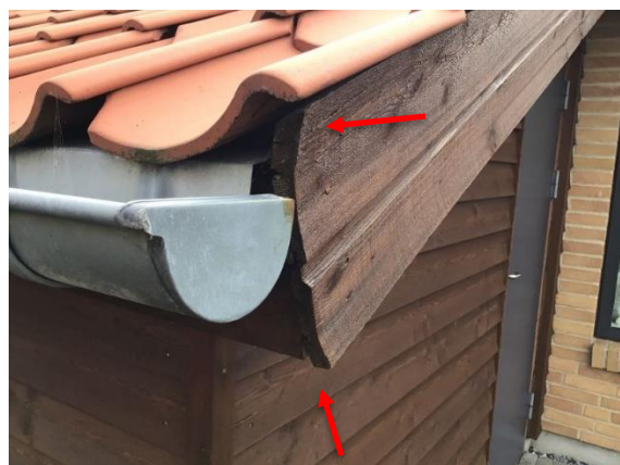
| Vindskede med vridskader.
