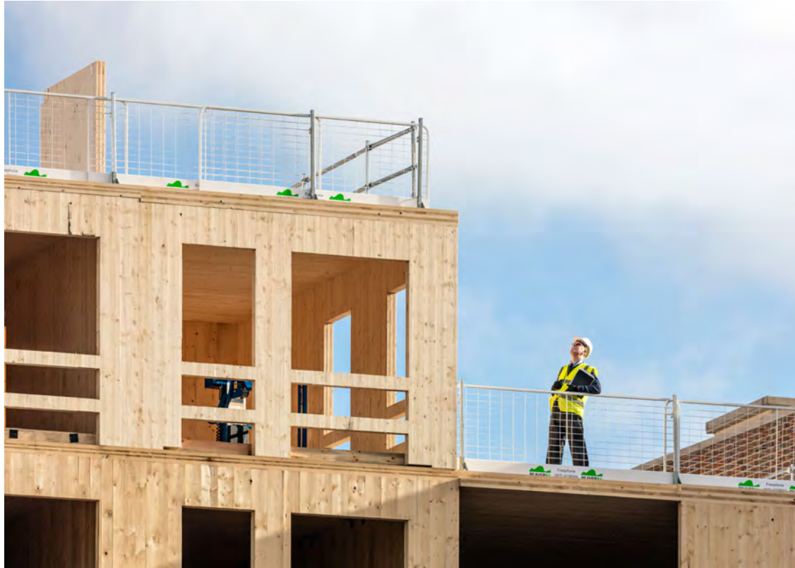
Vorfertigung Holzmassivbau Waugh Thistleton | @ Shearing
