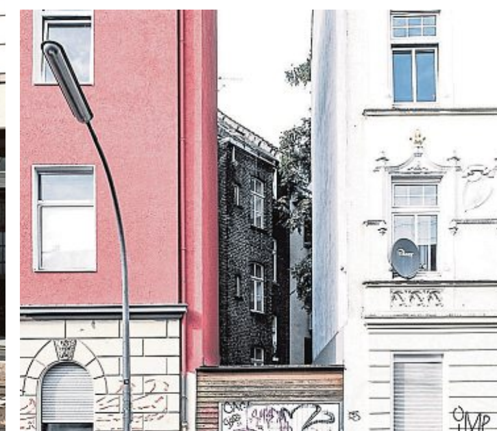
...und wie die Baulücke vorher aussah
