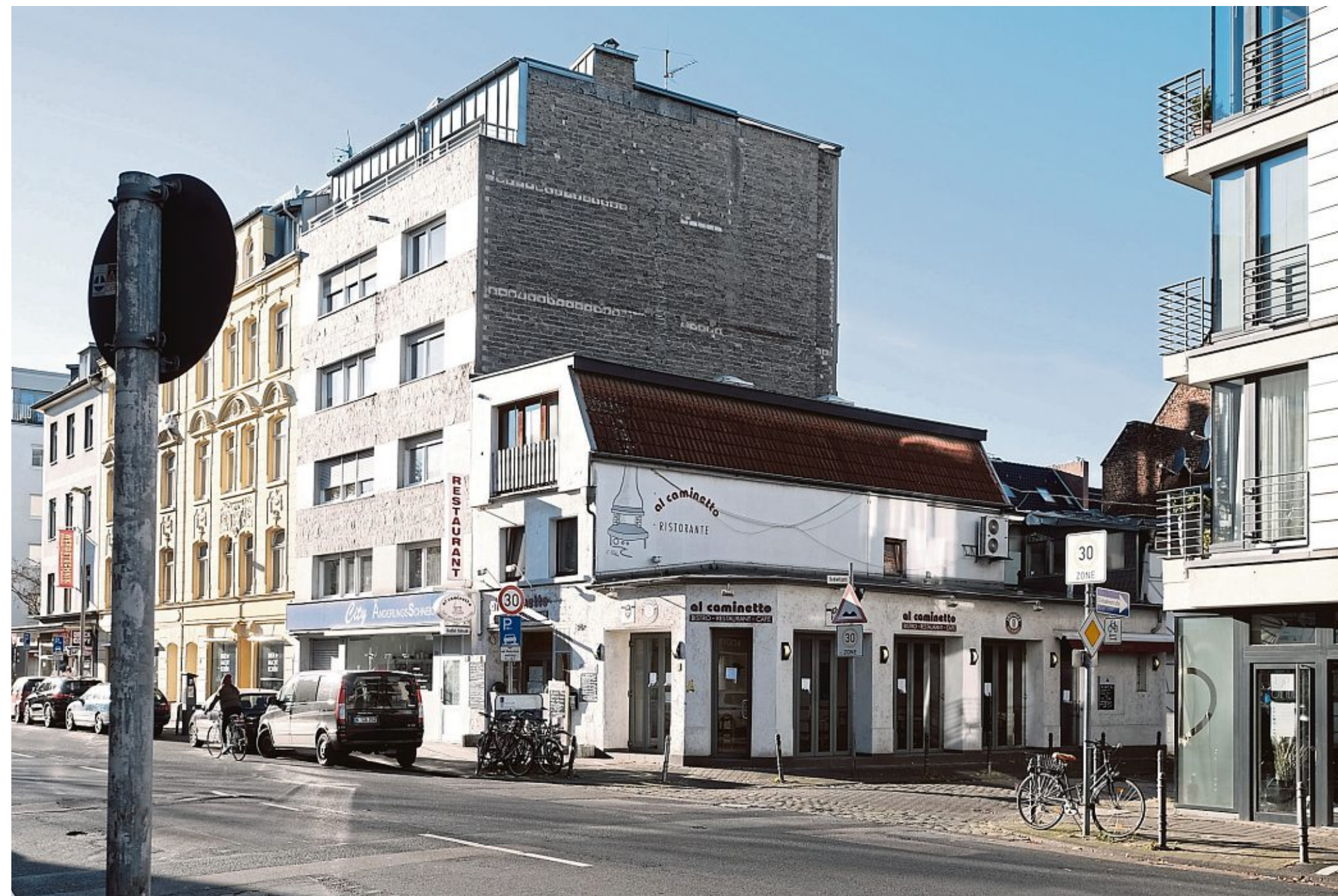
Es gibt viele Baulücken in Köln, die wenigsten werden sinnvoll bebaut. Hier eine Baulücke auf der Berrenrather Straße
