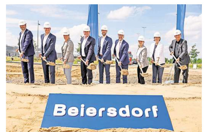
Ran an den Spaten: Mit diesem symbolischen Stich startet der Bau eines neuen Logistikzentrums der Beiersdorf AG im Leipziger Norden. Foto: Beiersdorf
