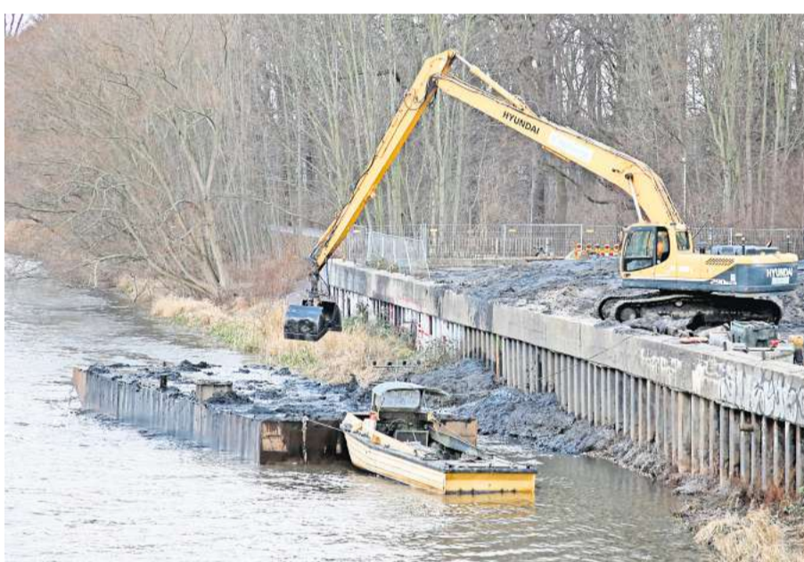
Im Elsterbecken wurde gestern Aushub abtransportiert. Besondere Vorkehrungen seien nicht notwendig, hieß es dort. Hochwasserschützer sehen das anders.
