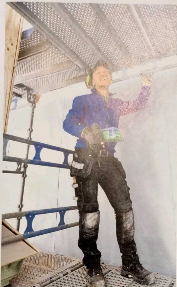
Plåtslagaren Michael Swedberg gillar att ha Storkyrkan som arbetsplats.
