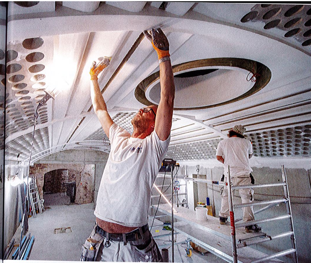
Betongtaket i den nya samlingsalen innebar en komplicerad gjutning för akustikens skull. Här spacklas taket av Mikael Strömstad och Fred Wallman från underentreprenören LP Måleri.
