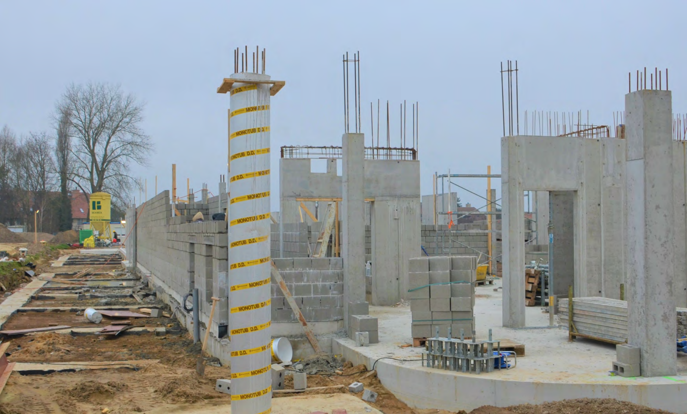
Zicht op de inkomruimte, met de reeds uitgevoerde betonwerken voor de liftkoker.
